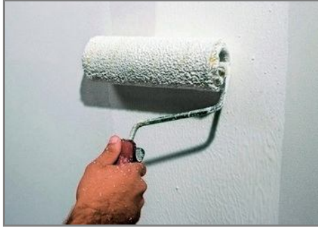
Step 1 - Start applying Primus Sabbia
