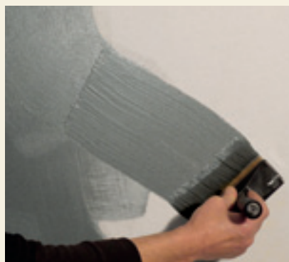
WOOL - Distribuire il prodotto casualmente Apply the product in a random way
